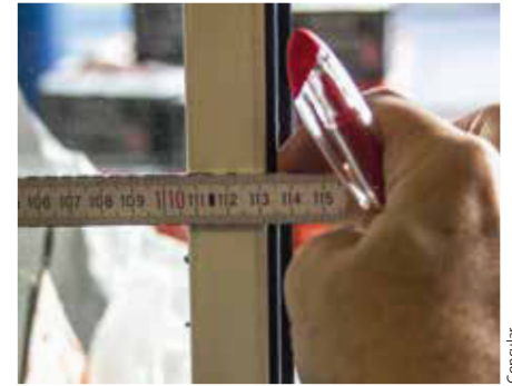
Das Sichten, Dokumentieren und Analysieren der einzelnen Bauteile und -materialien ist ein wichtiger Schritt bei mit Concular durchgeführten Rückbauprojekten.
