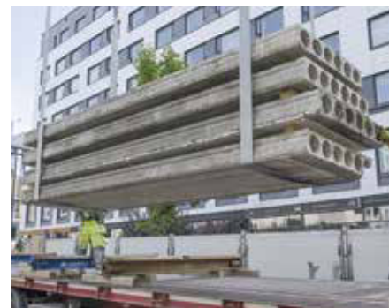
Beim EU-Projekt ReCreate werden an Standorten in Deutschland, Finnland, Schweden und den Niederlanden Betonelemente aus Spendergebäuden ausgebaut und damit neue Wohn- und Nutzungsbauten geschaffen.
